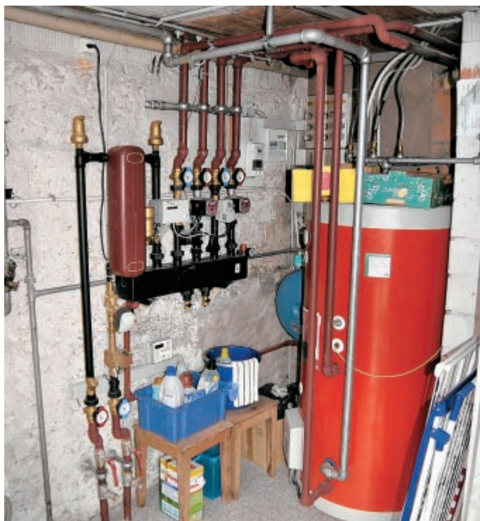
Der Plattentauscher benötigt im Haus des Wärmebezügers nur wenig Platz, dieser kann anders genutzt werden.
